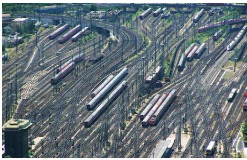
Głowica rozjazdowa (Frankfurt nad Menem) Head of turnouts (Frankfurt on Main)
